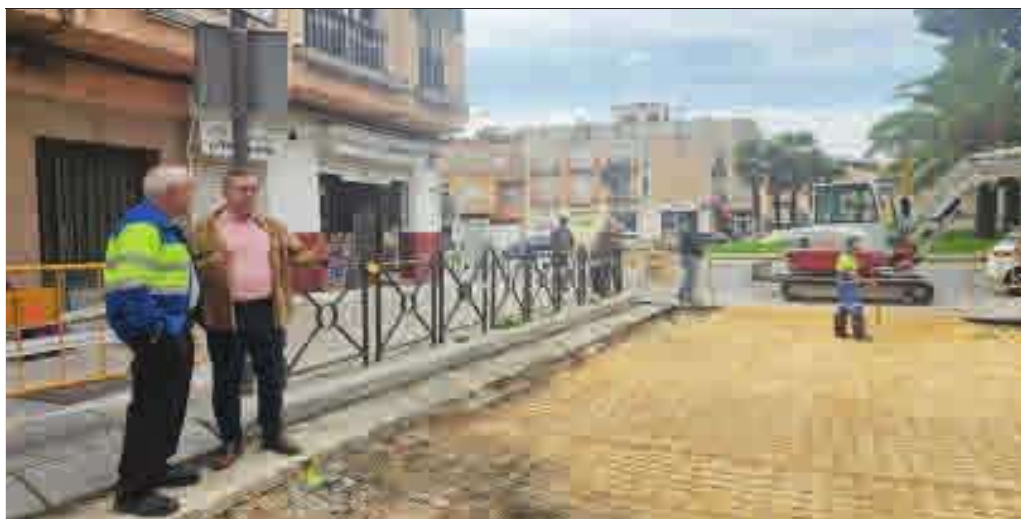
VISITA. El concejal Javier Padorno en la calle Ejido, donde se lleva a cabo la reparación de la avería.
