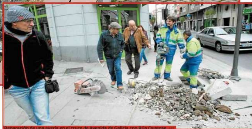
Reparación de una avería en el cruce de Avenida de Galicia con Rúa Ourense.
