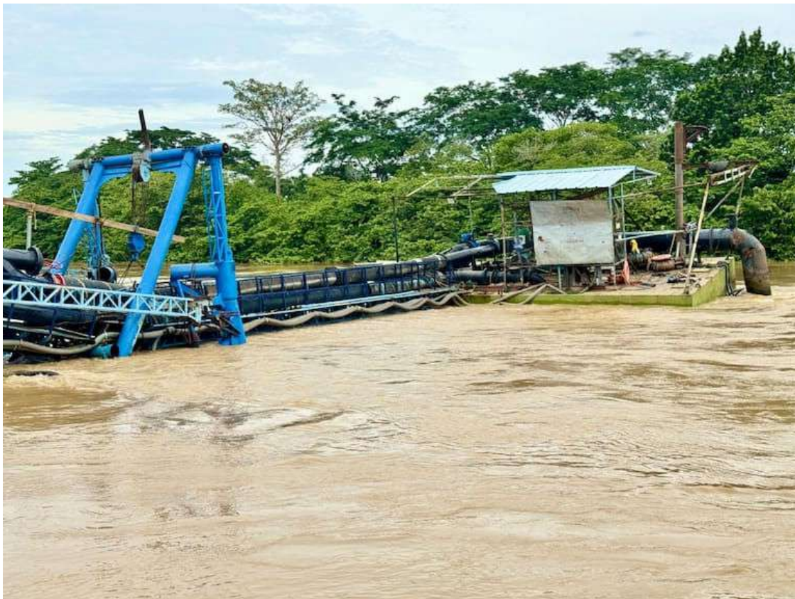
Aqualia activa plan de contingencia por afectaciones en el acueducto regional que abastece a Cereté, San Carlos, Ciénaga de Oro y Sahagún.
