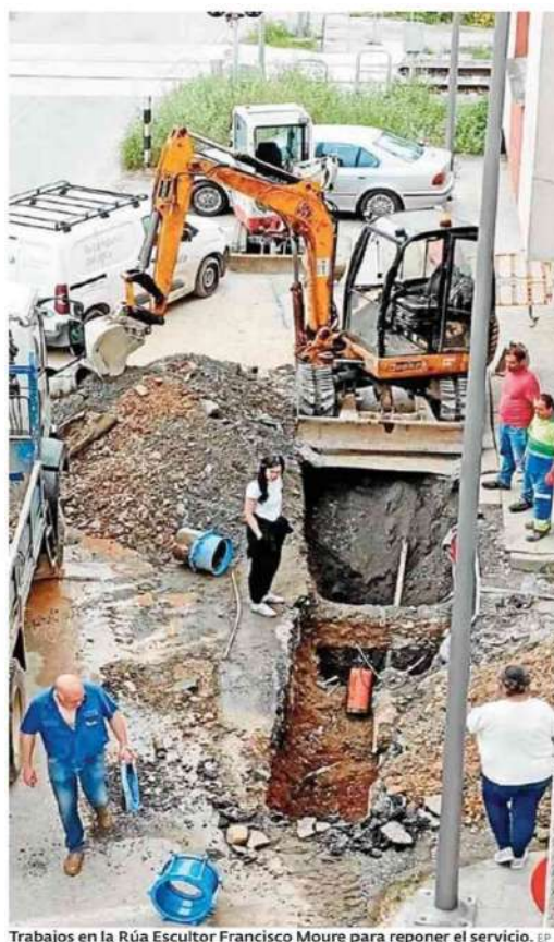
Trabajos en la Rúa Escultor Francisco Moure para reponer el servicio. EP
