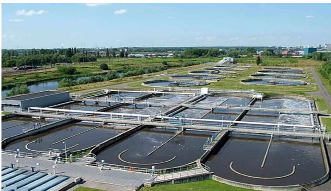
Cádiz acoge la primera planta demostrativa en España de generación de hidrógeno verde desde agua regenerada 1
