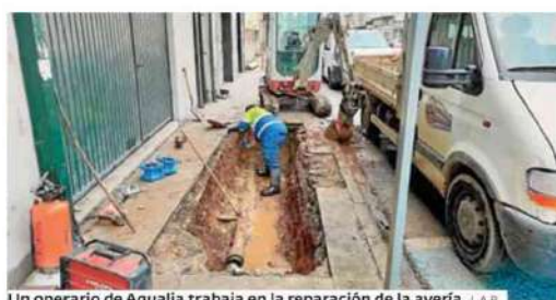
Un operario de Aqualia trabaja en la reparación de la avería. L.A.R.
